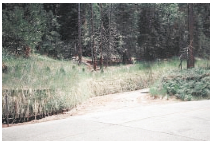
Подпорная стенка GEOWEB с взошедшей травой
