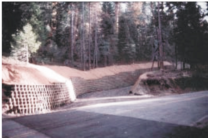
Вид готовой подпорной стены GEOWEB до гидропосева травы
