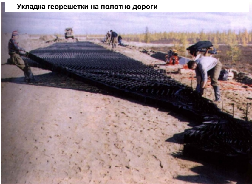
Участок автомобильной дороги подготовлен к засыпке песком
