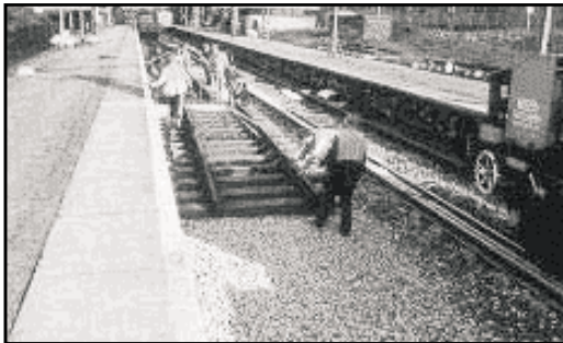
Для завершения балласта засыпается дополнительный слой щебня и затем рельсовый путь возвращается на место
