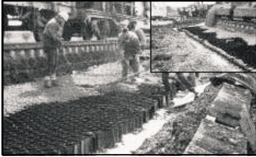
Каменный материал (щебень) укладывается, выравнивается и уплотняется в ячейках Geoweb
