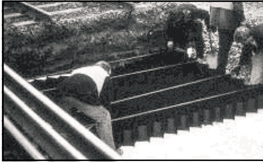
Укладка первого слоя секций Geoweb поверх геокомпозитного дренажного материала
