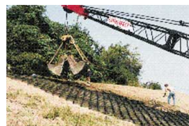
Заполнение ячеек Geoweb почвой
