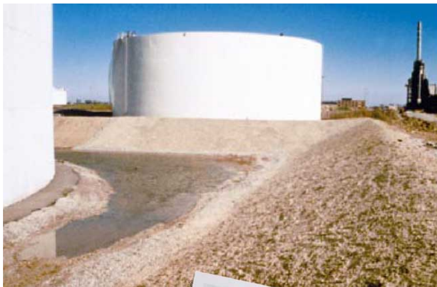
Рис. 3. Внешний вид законченной системы Geoweb с бетонным заполнением при обваловании резервуаров
