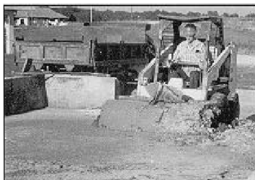
3. Усиленное при помощи системы Geoweb основание выдерживает легкий бульдозер для уборки осушенных отходов.
