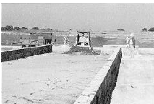
4. Заполнение и очистка системы площадью 850 м 2 выполняется менее чем за 48 часов.
