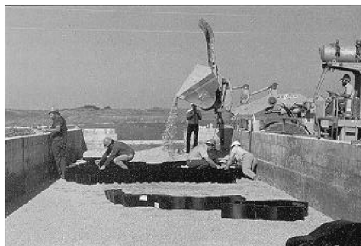
1. Секции Geoweb размерами 2.44 × 6.1 × 0.2м растягивались, скреплялись между собой и засыпались песком для фильтрации
