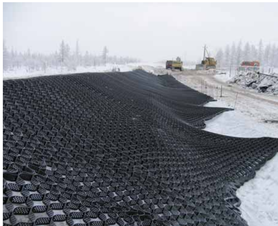
Технология ликвидации размывов откосов обвалования; 2-я нитка газопровода Заполярное - Новый Уренгой, декабрь 2004г.
