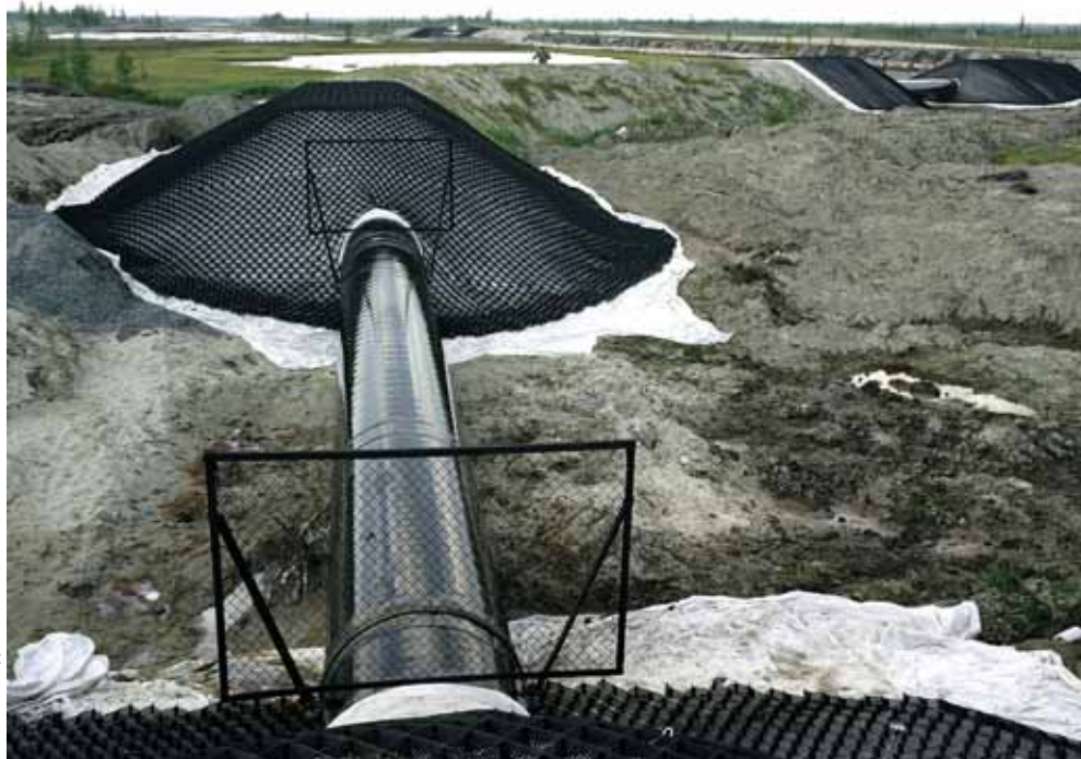
Технология укрепления воздушных переходов; газопровод Заполярное - Новый Уренгой
