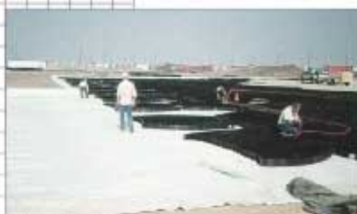
Соединение секций Geoweb
