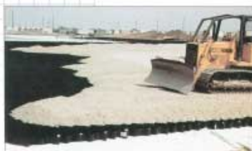
Заполнение секций Geoweb
