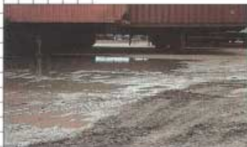
До укладки системы Geoweb
