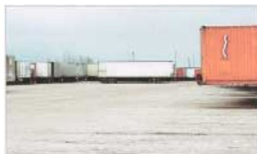
После укладки системы Geoweb
