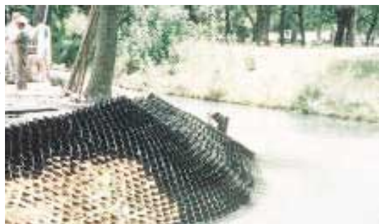
Гибкие секции GEOWEB укладываются на берег и закрепляются J-образными штифтами
