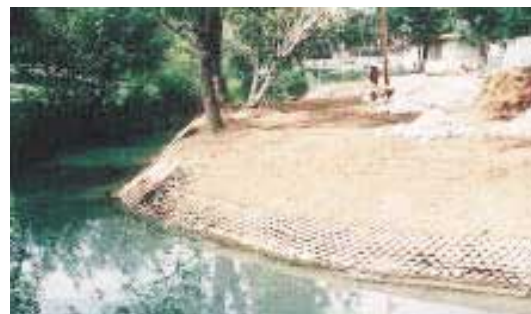
Гибкие секции GEOWEB укладываются на берег и закрепляются J-образными штифтами
