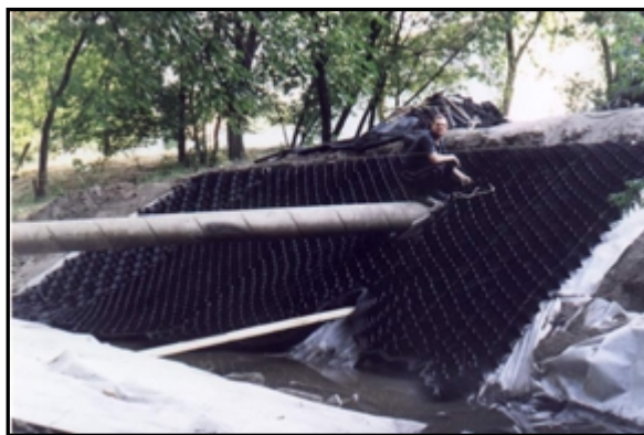
Растягивание и анкерение секций поверх геотекстиля
