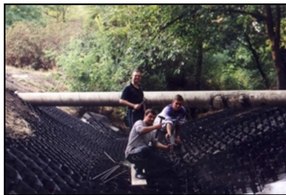
Анкерение георешетки по откосу и дну ручья арматурными анкерами АТРА®
