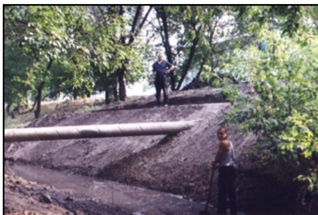
Поверхность прибрежных откосов тщательно спланирована.
