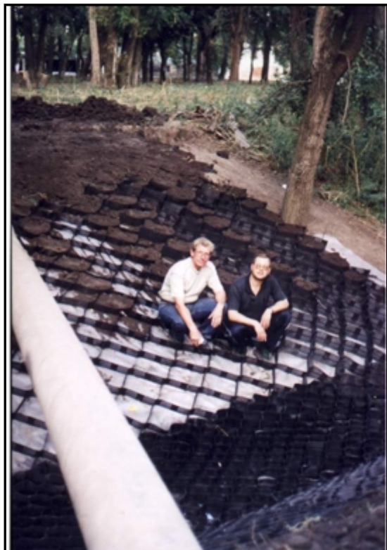
Георешетка засыпается растительным грунтом
