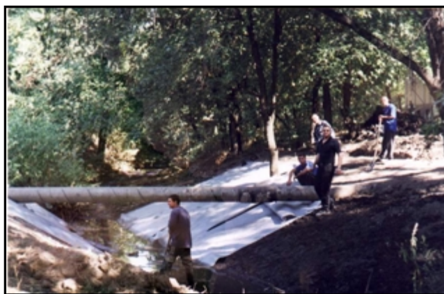
Расстилка нетканого материала (Тураг, фирмы «Дюппон»)
