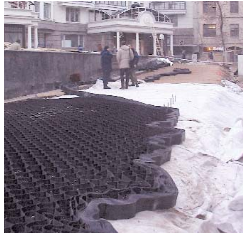
Укладка георешетки на подготовленное основание
